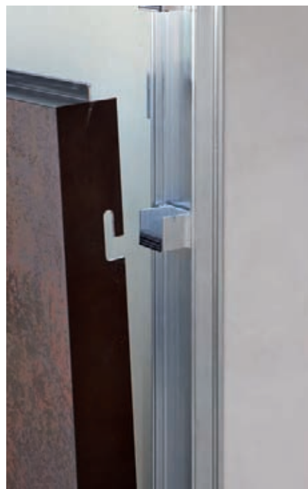
Particolare della sottostruttura verticale in alluminio con sistema di aggancio muniti di guarnizione antivibrazioni
