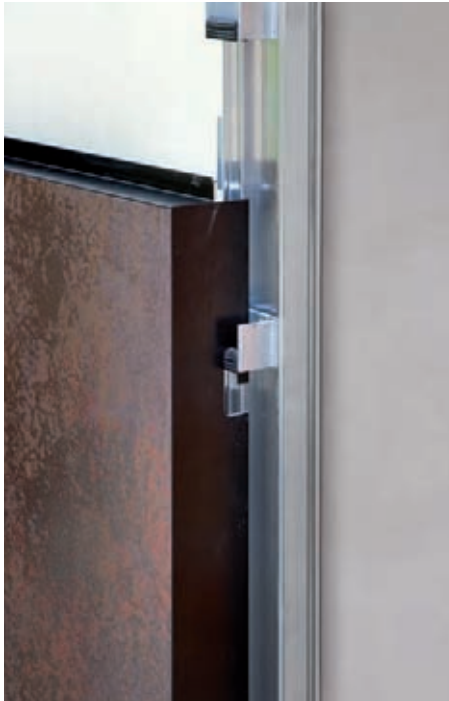
Ancoraggio meccanico del sistema di aggancio Mechanical anchorage of the fastening system
