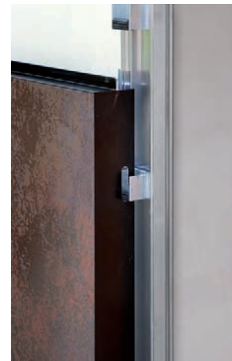
Accostamento del telaio alla sottostruttura
