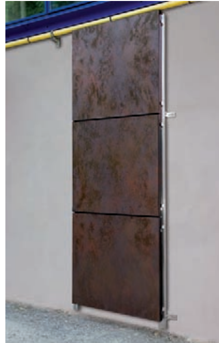
Esempio di porzione di facciata ultimata nel formato 1000x1000 mm
